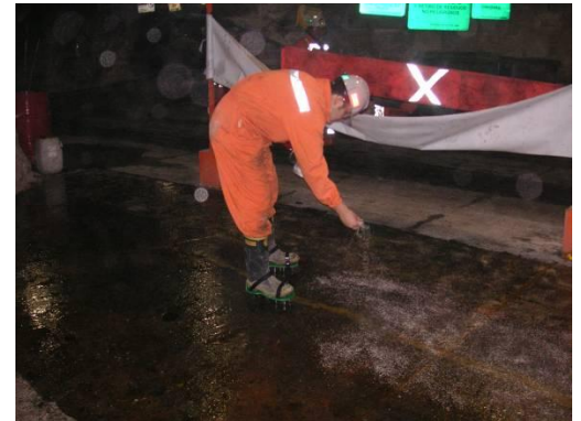
Figura N° 5.- Aplicación del producto Revepox 24 y posterior sembrado del filler.
