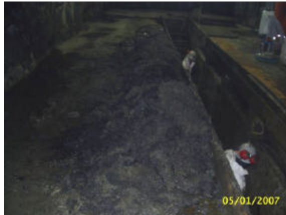
Figura N°1.- Estado inicial Nave de lavado de equipo LHD, Fortuna Regimiento.
