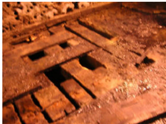
Figura N°2.- Estado inicial superficie Pozos de Mantenimiento. Pozo 1 y Pozo 2.
