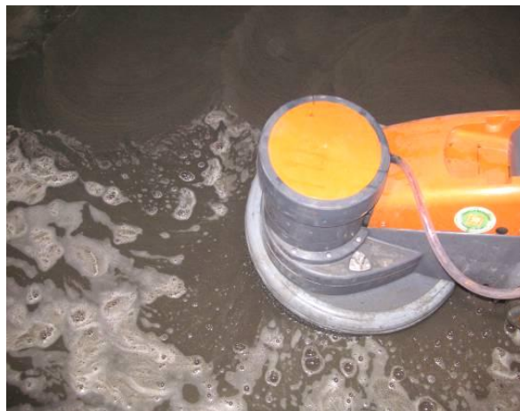
Figura N° 2.- Proceso de fregado del piso.
