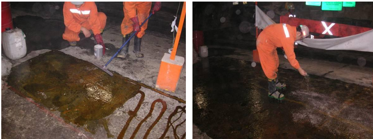
Figura N° 5.- Aplicación del producto Seirepox 24 y posterior sembrado del filler.
