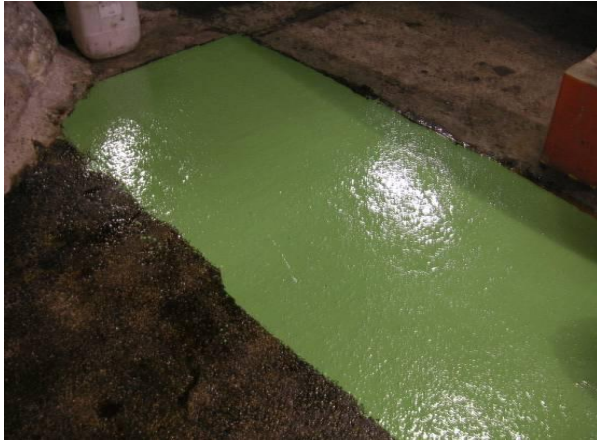
Figura N° 6.- Aplicación del producto Seirepox Multicapa 280.
