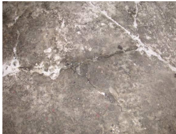
Figura N° 3.- Estado del piso después de la limpieza física y biológica, nótese el nivel de limpieza logrado.
