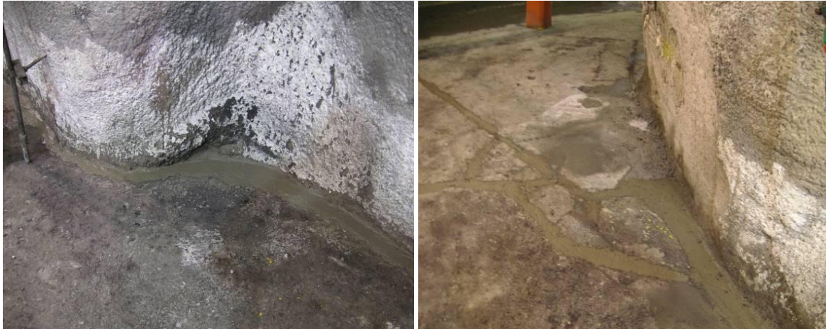
Figura N° 4.- Reparación de imperfecciones.
